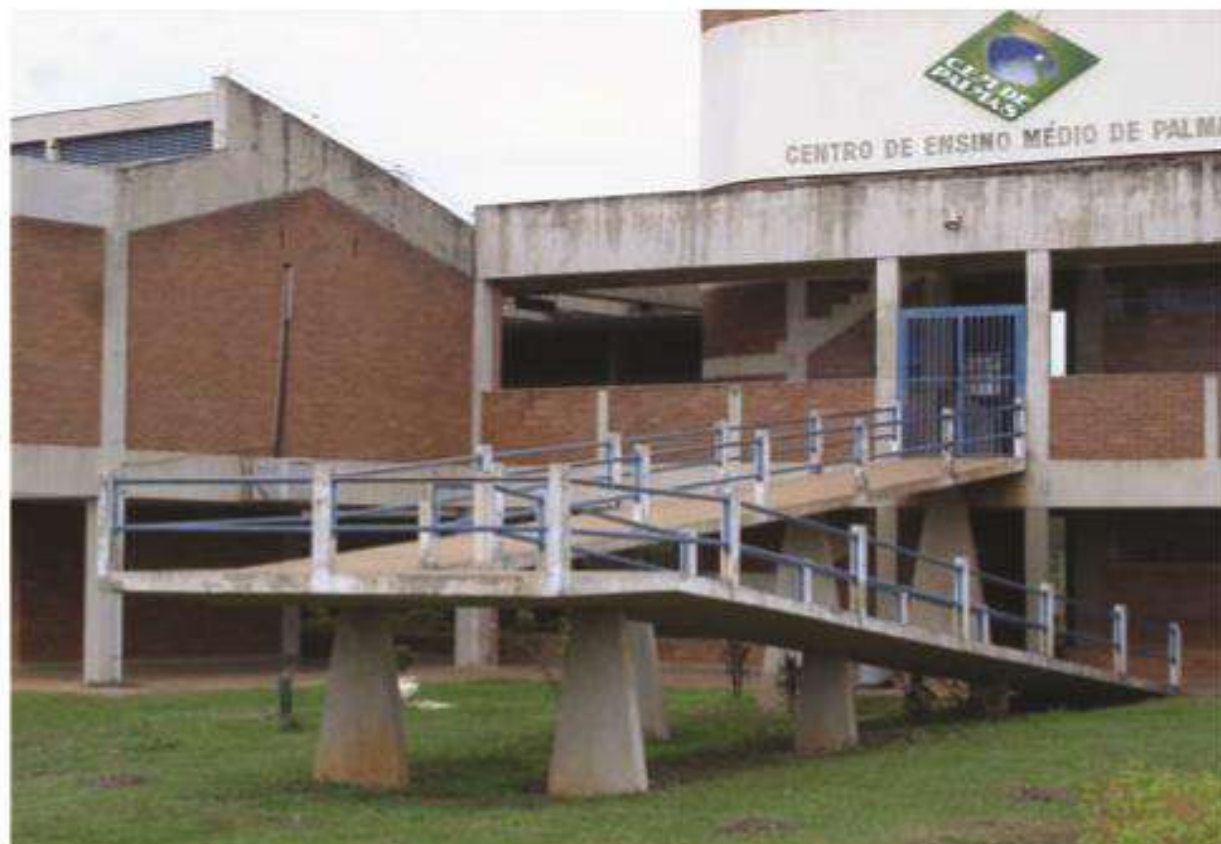
Foto 8: Exemplo de rampas de acesso a edifício escolar em Palmas. A declividade e o comprimento de cada lance da rampa devem respeitar a norma técnica.
