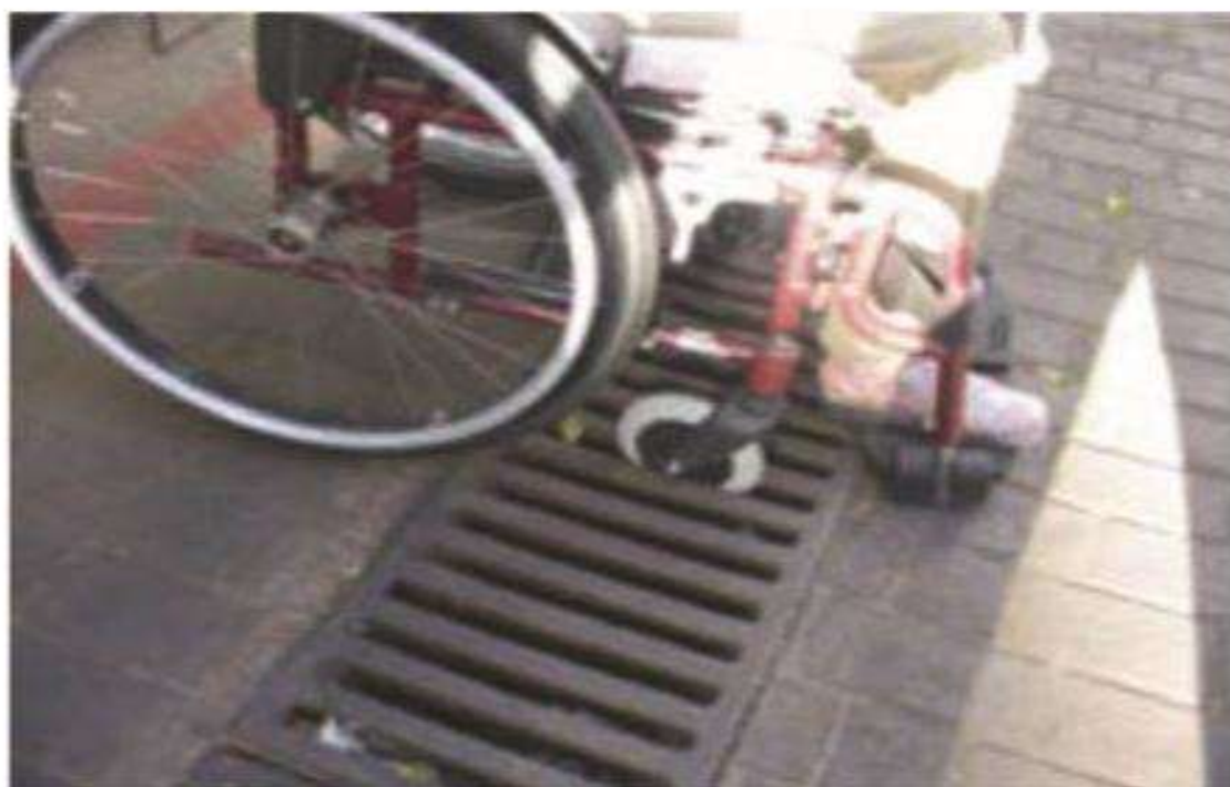
Foto 13: Exemplo de grelha inadequada. (Fonte: Brasil. Ministério das Cidades. Caderno do Programa Brasil Acessível)
