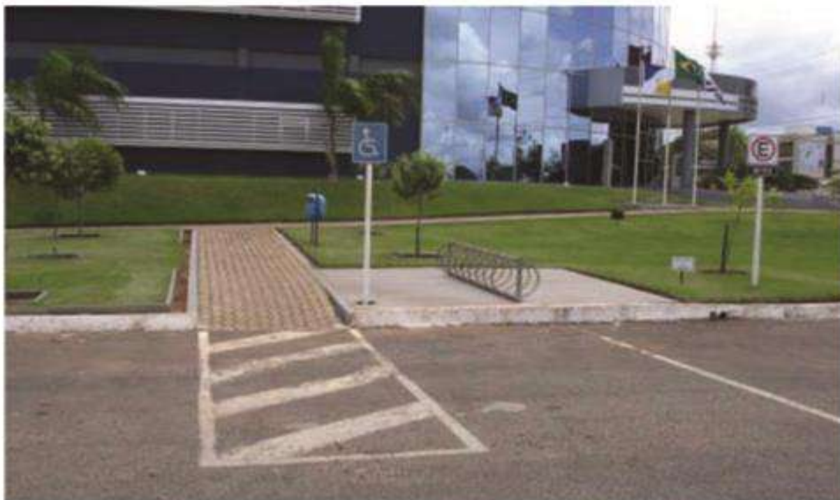
Foto 14: Exemplo de vaga demarcada para deficiente físico, com devida área de acesso lateral e guia rebaixada.
